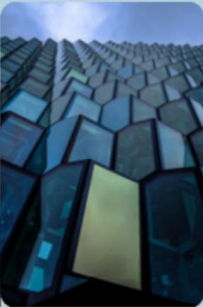
Con un uso minimo di materiali ed energia è possibile creare pareti edilizie leggere ma ad alta resistenza, un'isolazione efficace e serbatoi con grande capacità. Questa struttura può essere utilizzata in modo efficiente anche nelle carrozzerie di veicoli e aeromobili, oltre che nei materiali di imballaggio.
